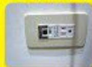
插座型漏電斷路器
